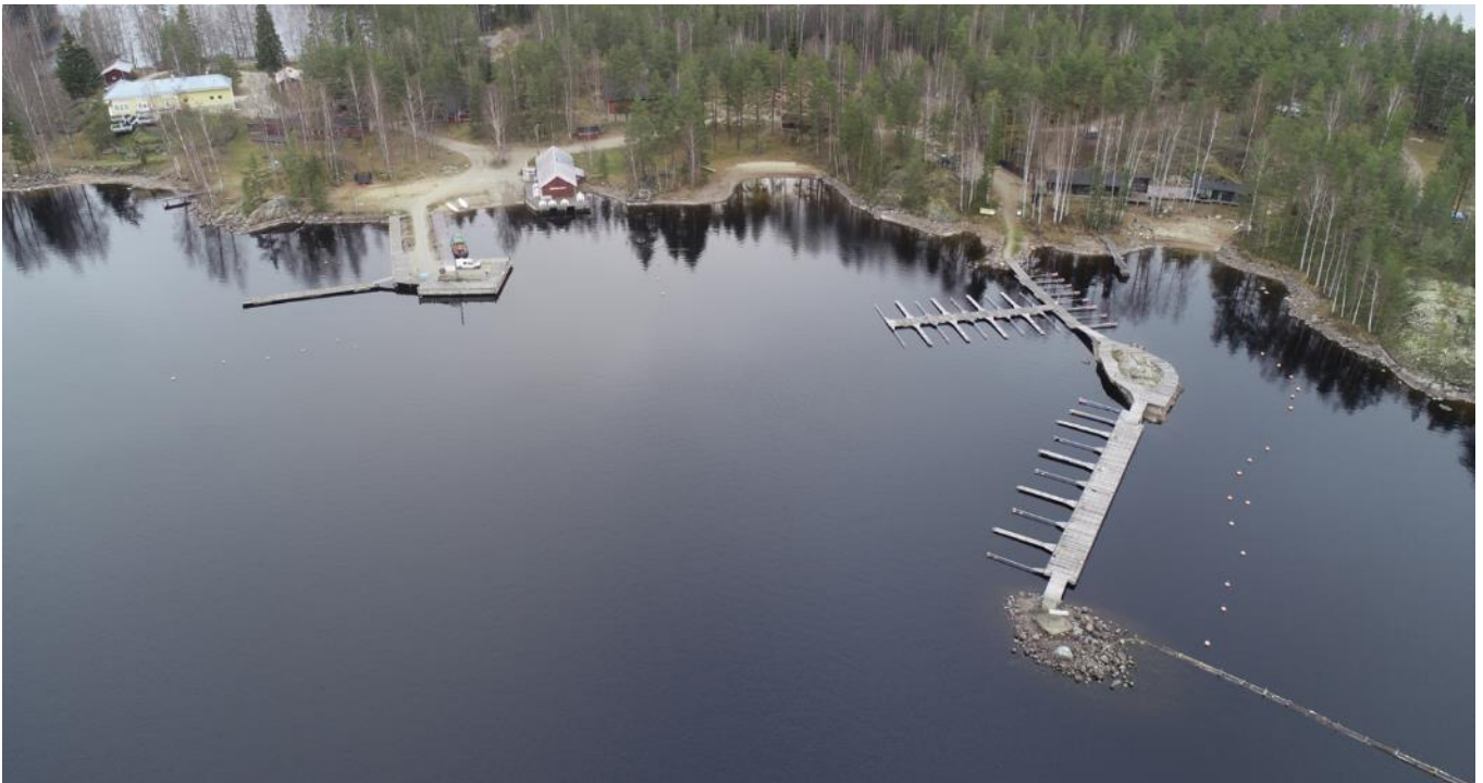
Kuvat: Kuvassa on nähtävissä Sahanlahti Resortin keltainen päärakennus sekä vierasvene- ja kotisatama-alueet.
